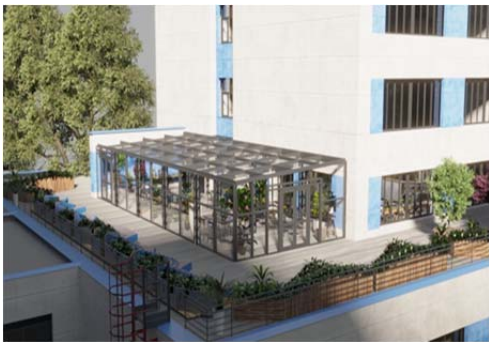
Рисунок 1 – Светопрозрачный атриум, расположенный в уровне эксплуатируемой кровли первого этажа
