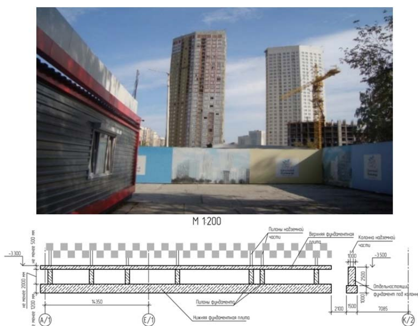
Рисунок 1 – Высотные одинаковые жилые дома в Екатеринбурге: слева на плитном фундаменте (расчет по нелинейной теории); справа на свайно-плитном фундаменте (стоимость свайно-плитного фундамента на 40 млн рублей больше)
