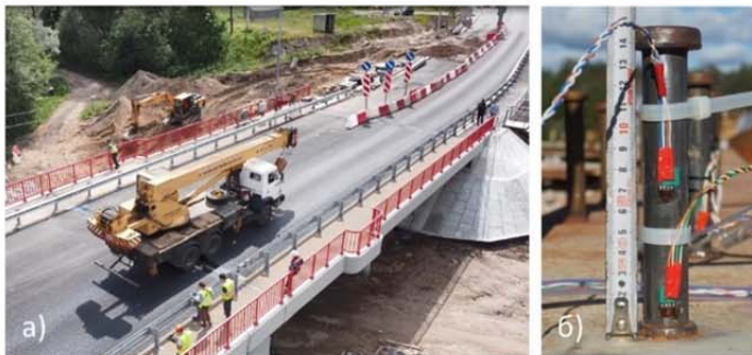
Рисунок 1. а) Проезд испытательной нагрузки по мосту; б) Элементы измерительной системы на ГШУ.
